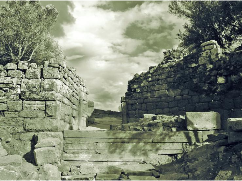
Fig. 12. Demirkapı'nın batıdan (dıştan) görünümü.
