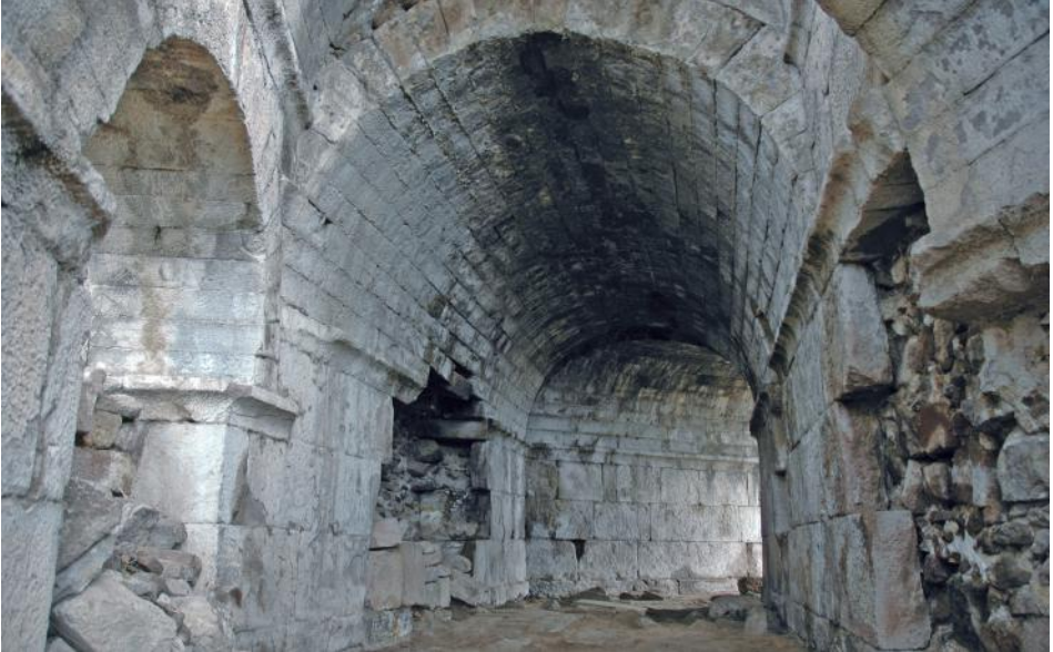
Fig. 13. Aigai Tiyatrosu'nun Vomitorium'u (Giriş Binası).
