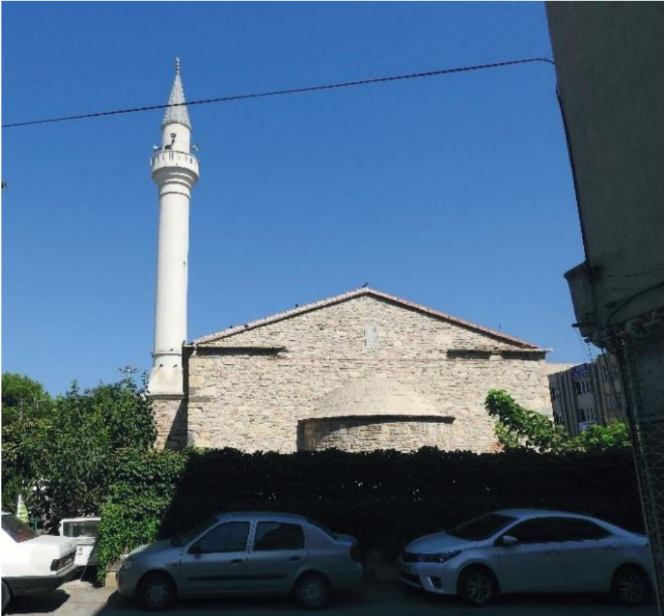
Fig. 19. Aliağa Çarşı (Merkez) Camii. Güneyden görünüşü.
