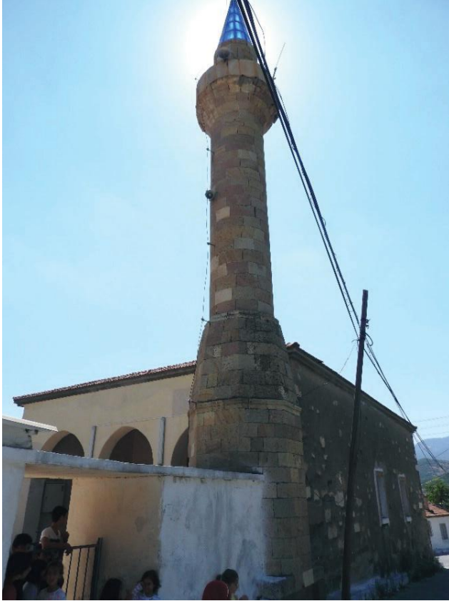
Fig. 10. Aliađa, Güzelhisar Köyü Ali Ađa Camii. Kuzeybatıdan görünüş.
