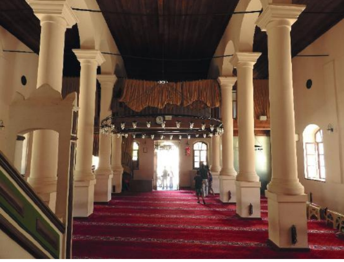
Fig. 23. Aliğa Çarşı (Merkez) Camii. Harimin içten görünüşü, güneyden kuzeye bakış.
