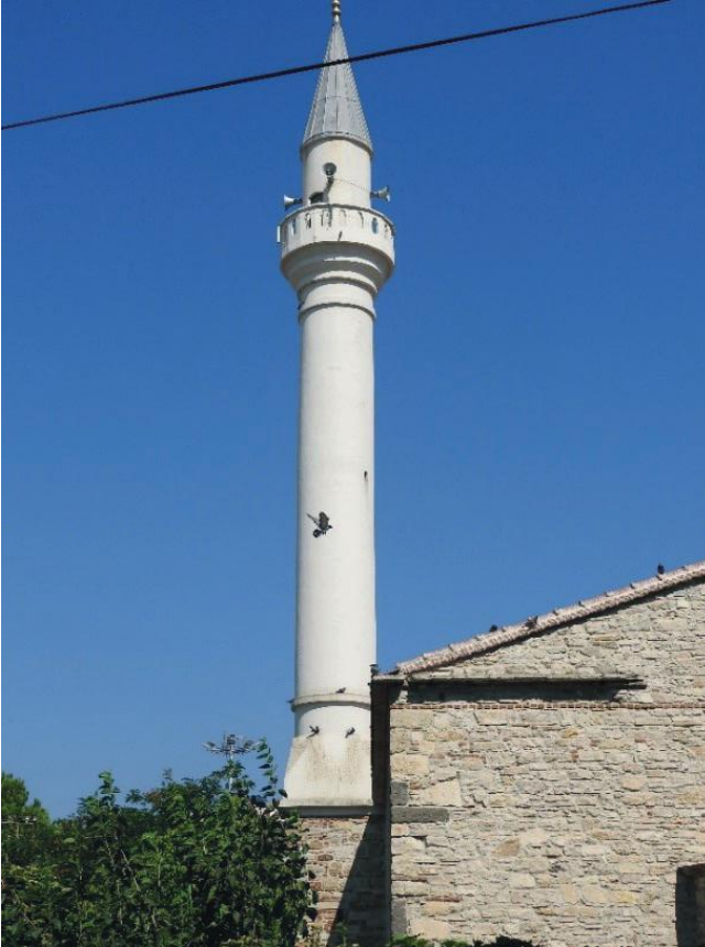
Fig. 18. Aliğa Çarşı (Merkez) Camii. Minare.
