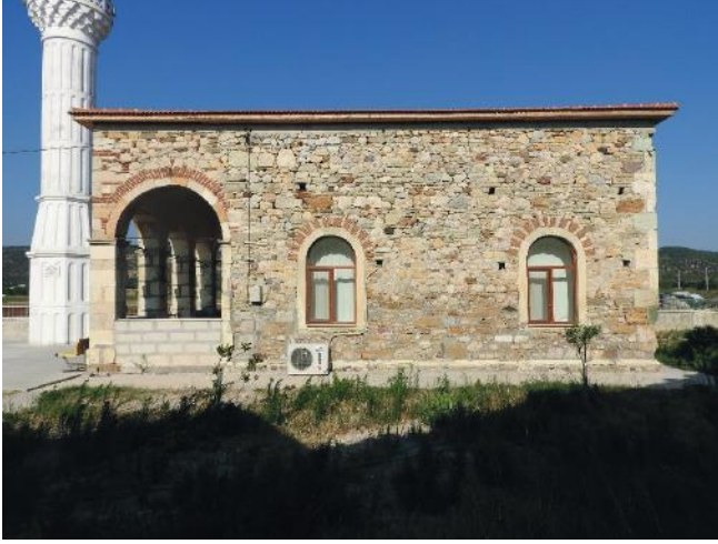
Fig. 34. Aliğa, Yenişakran Köyü Reşadiye Camii. Batı cephesi.
