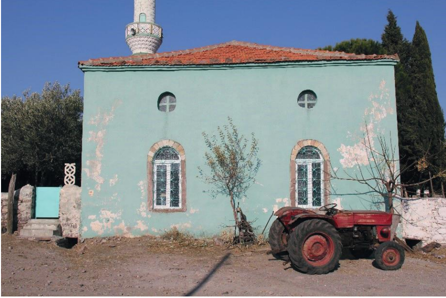
Fig. 28. Aliğa, Yukarışakran Köyü Camii. Güney cephesi.
