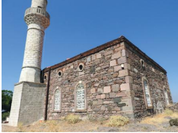
Fig. 39. Aliağa, Eski Hacıömerli Köyü Camii. Güneybatıdan görünüşü.
