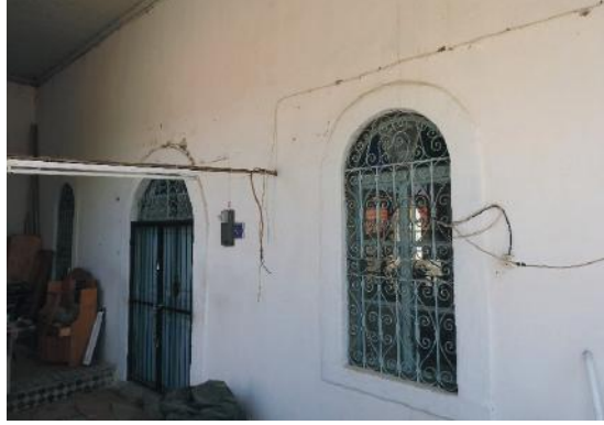
Fig. 43. Aliağa, Eski Hacıömerli Köyü Camii. Harim girişi.
